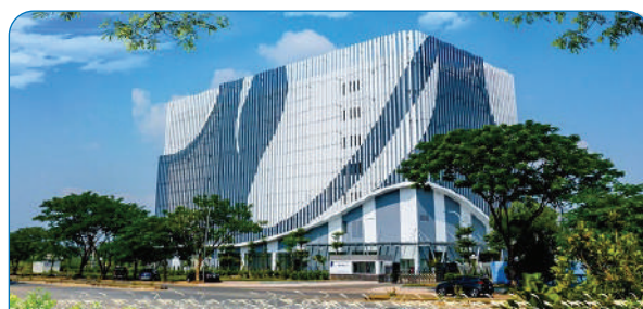
CÔNG TY VNPT IDC Khu Chế Xuất Tân Thuận, Quận 7, TPHCM
