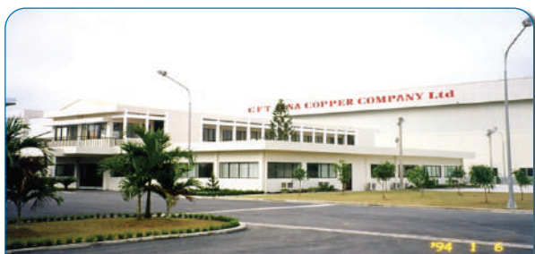
CÔNG TY DÂY ĐỒNG VIỆT NAM CFT Khu Công Nghiệp Long Đức: Đường D3-3, Xã Long Đức Huyện Long Thành, T.Đồng Nai
